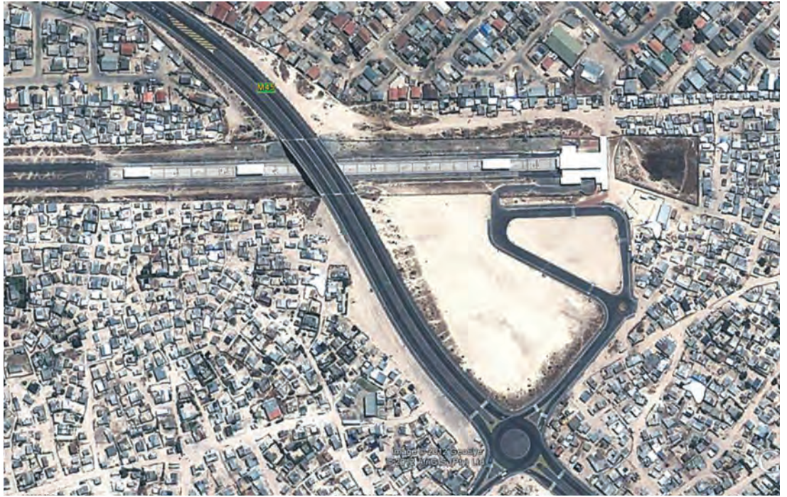
Chris Hanı metrorail station, Khayelitsha
